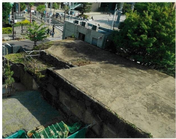
東側の石垣上部
