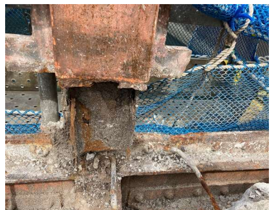
【地覆撤去・高欄接合部】
