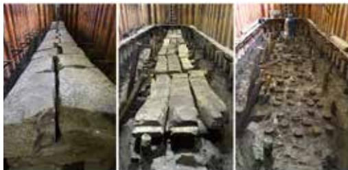
図9 常盤橋基礎構造 (左: 巻出石中: 捨土台 右: 地形杭)
