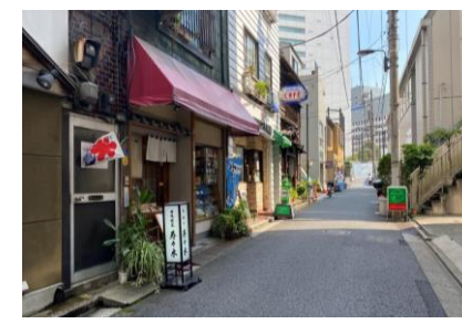
5. 防災性に課題がある老朽化建物 ・狭隘な4m幅員の区道に面して防災性に課題のある建物が残っている
