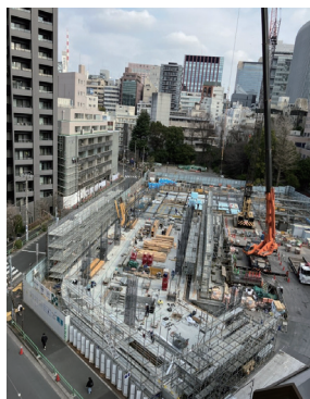
工事中のお茶の水小学校
