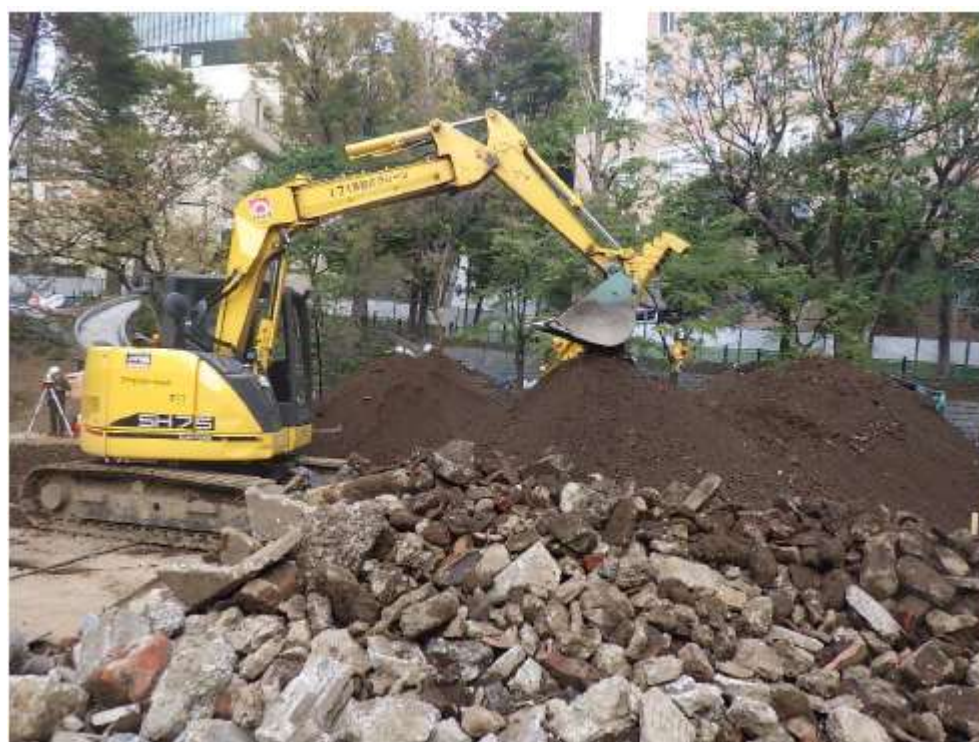
地中障害物ふるい分け状況（土砂・地中障害物）
