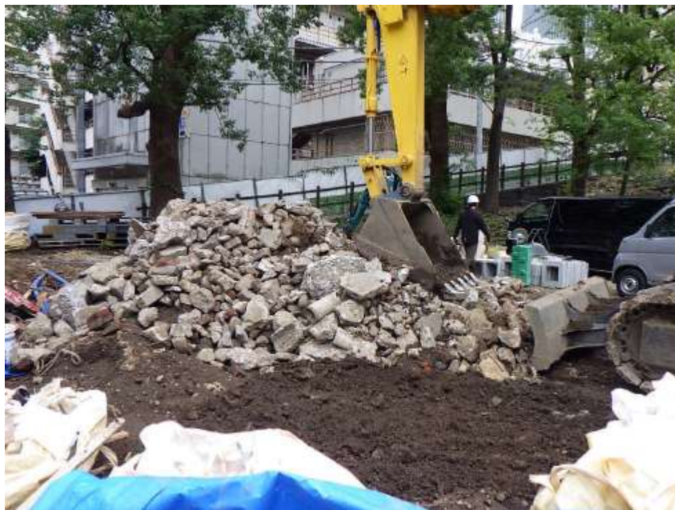
地中障害物集積状況
