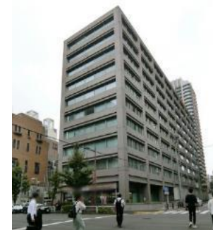
SC神田錦町三丁目ビル 外観
