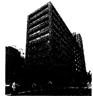
SC神田錦町三丁目ビル 外観
