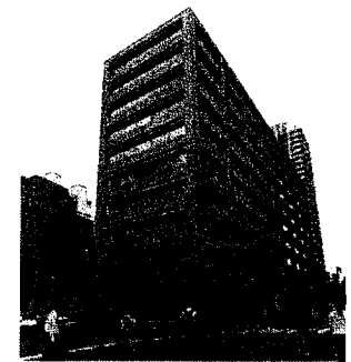
SC神田錦町三丁目ビル 外観
