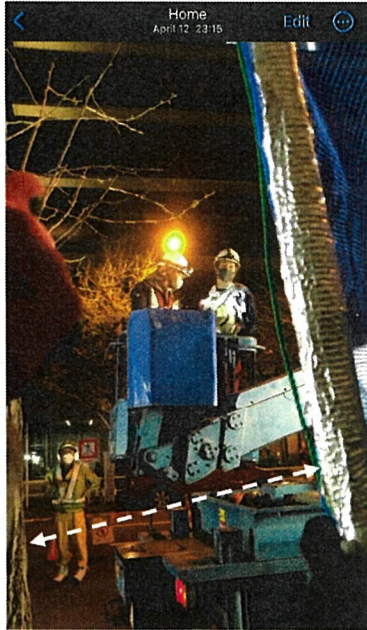
ネットでは伐採した木やチェーンソー等の工具が落下しても防げない。また、ネットとネットの間にも隙間もあった。
