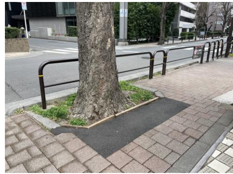
根張りを切除して段差解消した事例
