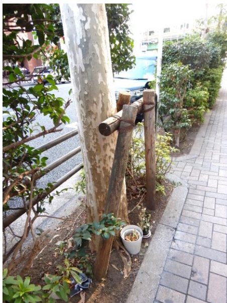
図-19 腐朽した樹木支柱の残置
