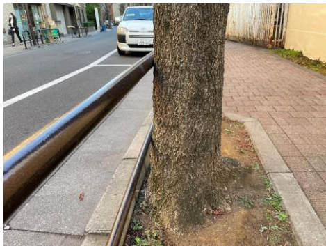
図ー15 幹とガードパイプの接触
