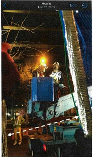
ネットでは伐採した木やチェーンソー等の工具が落下しても防げない。また、ネットとネットの間にも隙間もあった。
