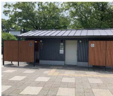
バリアフリー対応のトイレ/九段坂公園
