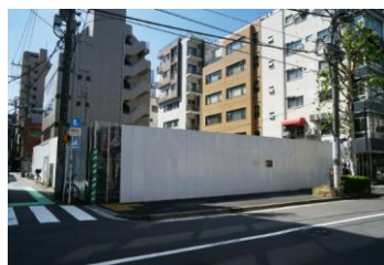
旧和泉町ポンプ所跡地
