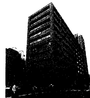
SC神田錦町三丁目ビル 外観
