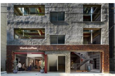
リノベーション事例： 上：神田ポートビル 下：岡田ビル
