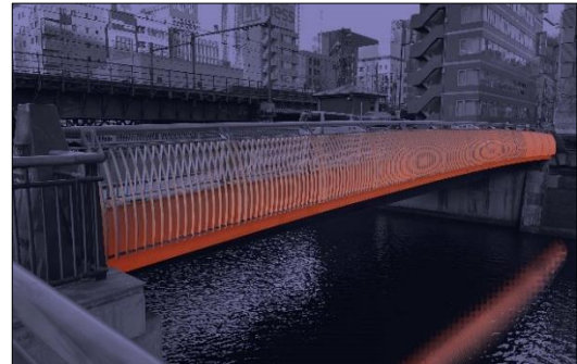
新三崎橋 〔ライトアップ箇所〕 ・ 高欄（下流側）
