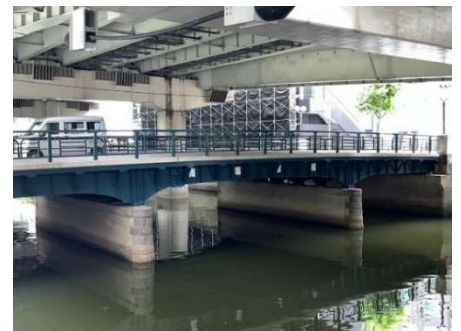
【南堀留橋(完了後)】
