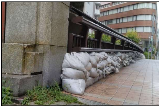
新川橋土のう積載（台風第6号）
