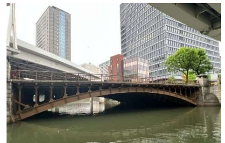
【雉子橋(塗装完了後)】
