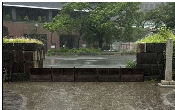
常盤橋公園止水板設置（台風第6号）
