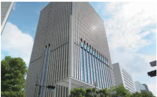
千代田区役所本庁舎
